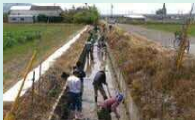
開水路の清掃
