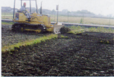
区画拡大 施工状況
