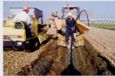
暗渠排水 施工状況
