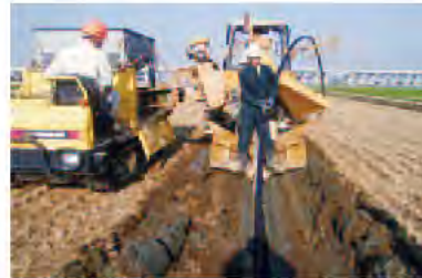
暗渠排水 施工状況
