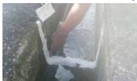
⑥側溝となじむように擦り付けを行う ↓
